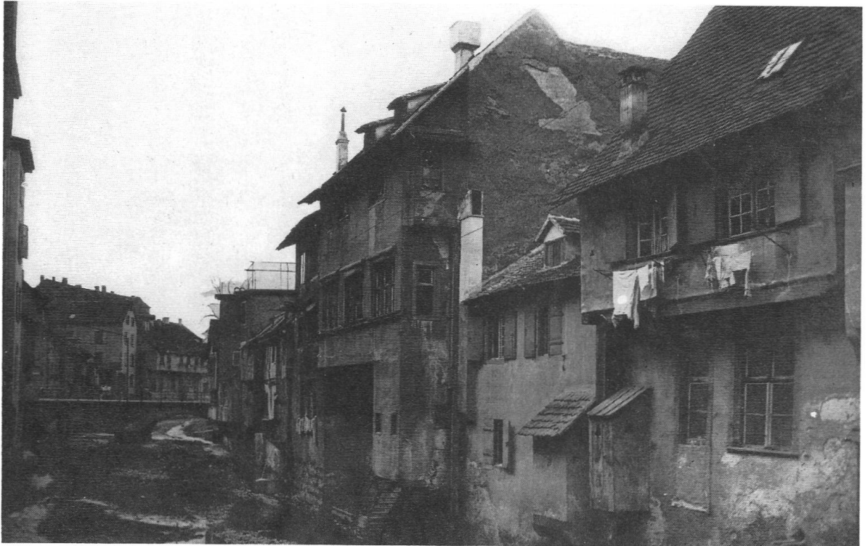
Abb. 28 Birsig unterhalb des Theaterstegs.
