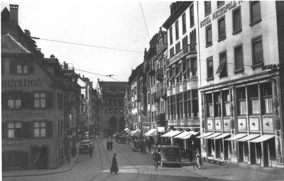
Abb. 30 Endgültig überwölbter Birsig.
