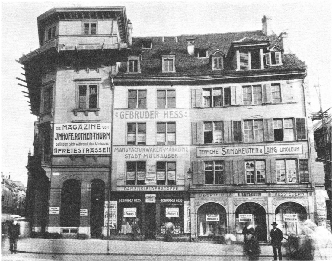
Firmen Imhoff z. Rothen Thurm, Magazine zur Stadt Mülhausen, Sandreuter vormals Brüderlin. Das Naphtalygebäude ist bereits abgebrochen. 1907.
