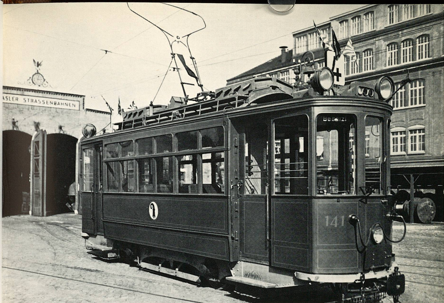
Motorwagen 141 (SWS/BBC) aus einer Serie von zwölf Wagen, die 1914 in Betrieb kamen.
