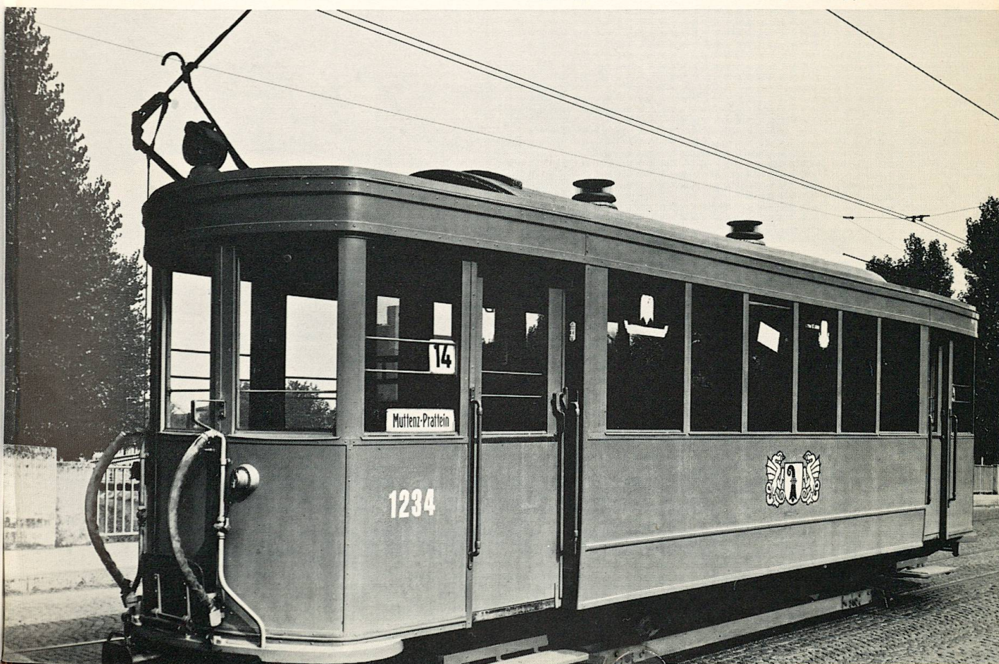
Anhänger 1234 (SWS) ist der letzte einer Reihe von zwölf Wagen gleicher Bauart aus dem Jahre 1932.
