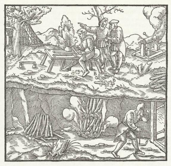
Abbau des Erzes durch Feuersetzen
