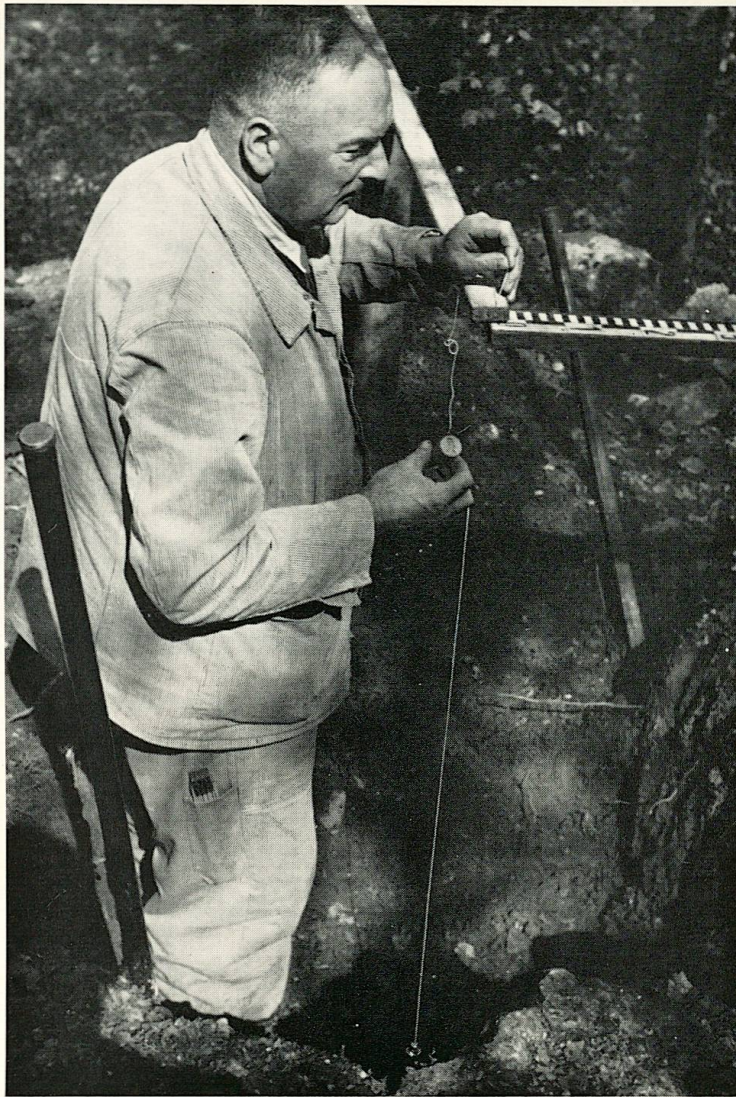
Bild 17 Hinuntersenkeln der Lohen
