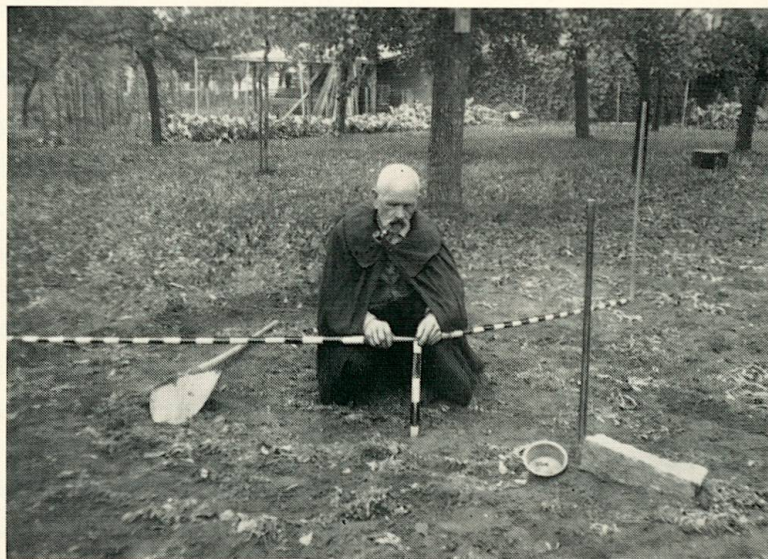
Bild 16 Einmessen eines Grenzpunktes
