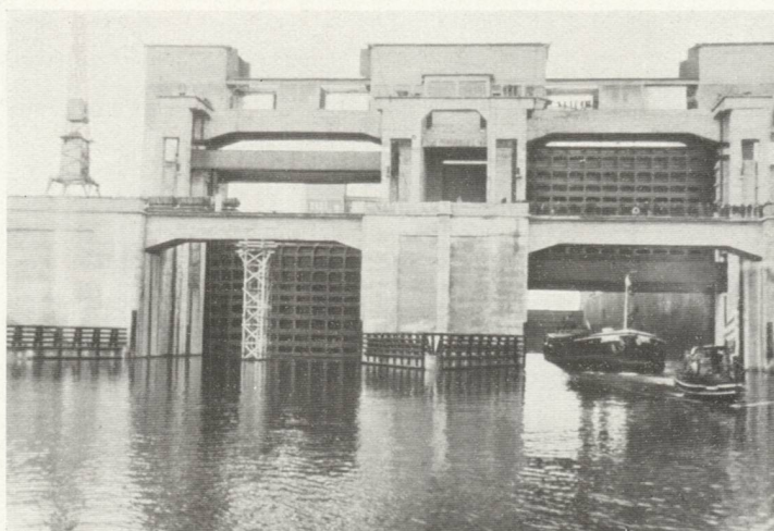
Abb. 79. Grossschiffahrtsschleuse bei Kembs.
