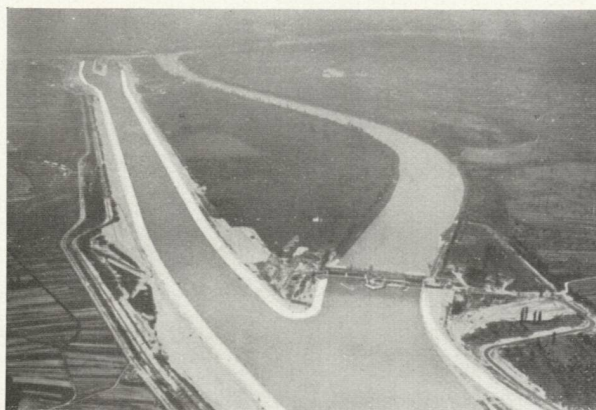
Abb. 77. Oberwasserkanal und Stauwehr Kembs.
