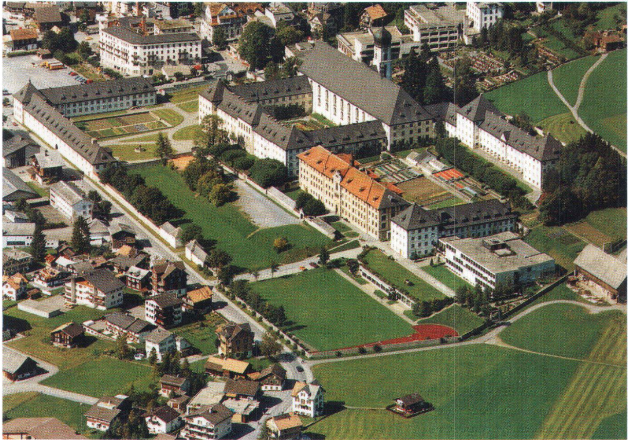
Abb. 17: Gesamtansicht des Benediktinerklosters und der Stiftsschule Engelberg von Südosten, Zustand um 1977. Foto: Air-Color S.A., Chambésy.
