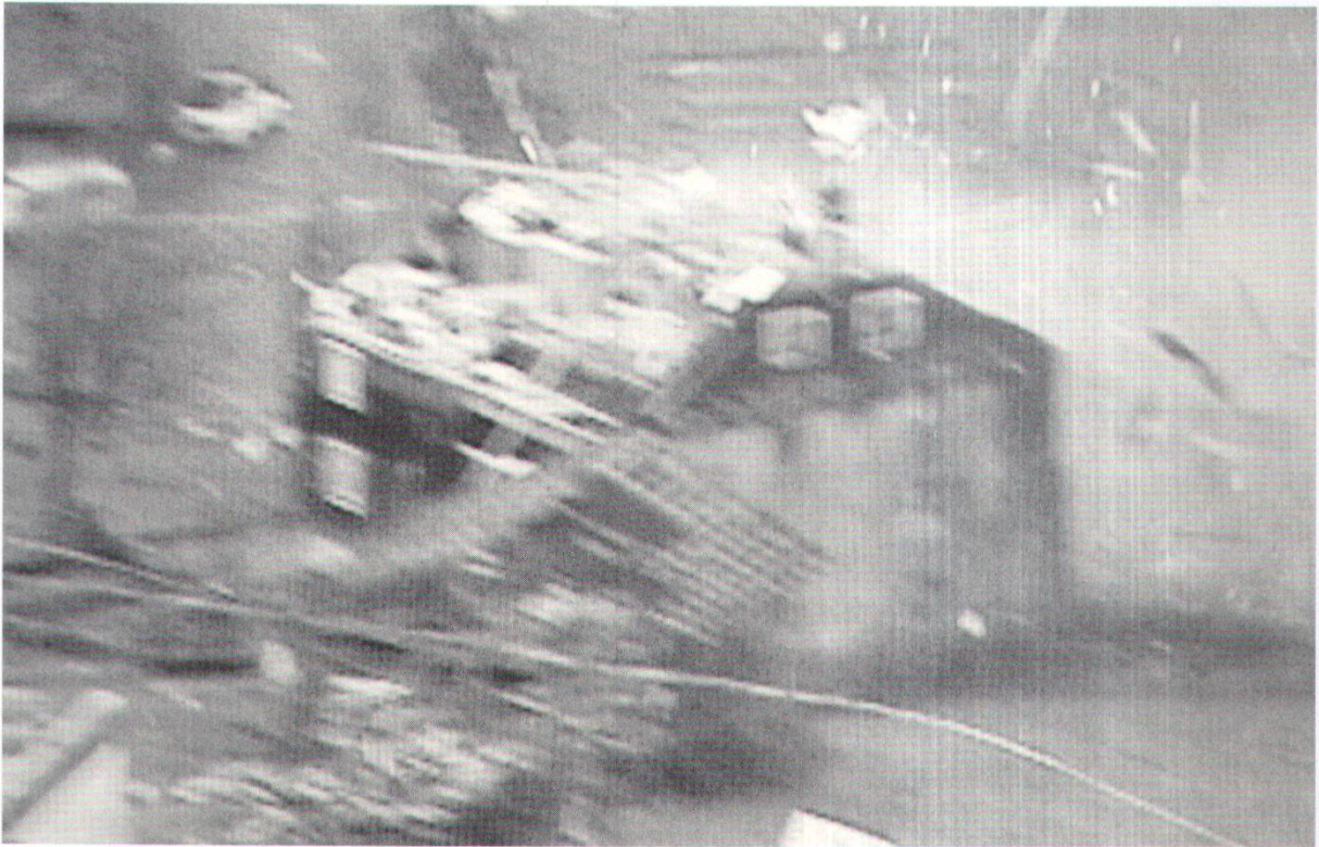
Abb. 1: Die hohen Windgeschwindigkeiten von «Lothar» zerrissen in Oberdorf ein Haus. Zusammen mit der Dauer eines Sturmes sind die Windgeschwindigkeiten und die Böigkeit entscheidend für die Höhe der angerichteten Schäden. Abbildungsnachweis: PFISTER, Naturkatastrophen (wie Anm. 10), S. 17. Abgedruckt ist das Bild auch in WSL/BUWAL, Lothar (wie Anm. 7), S. 101.
