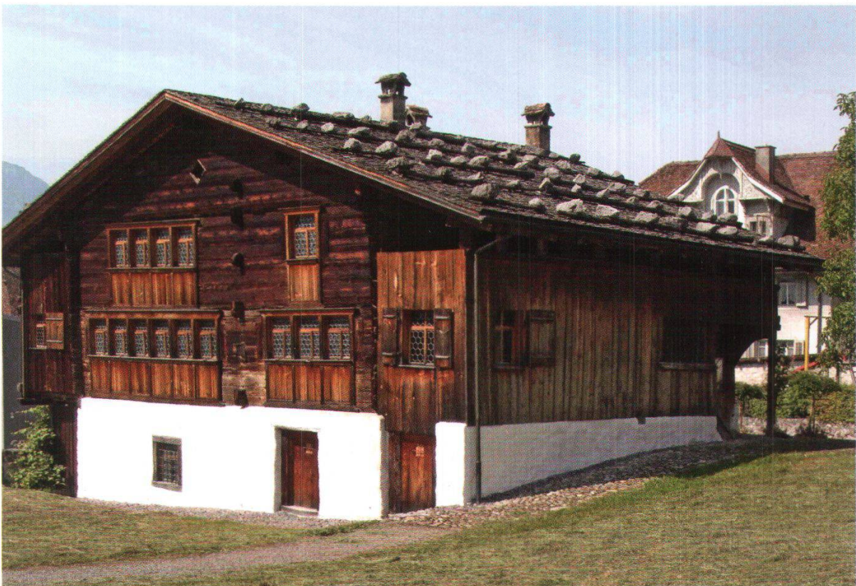
Abb. 7: Hochmittelalterlicher Blockbau: das Haus Bethlehem in Schwyz. Die Fensteröffnungen und die Verschalung der Lauben sind neuzeitlich, die Dachdeckung ist modern.
