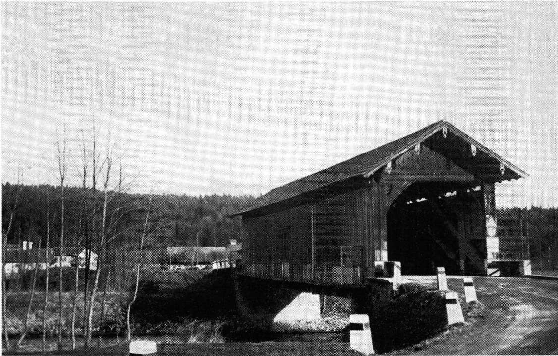
Brücke über die Emme bei Brunau
