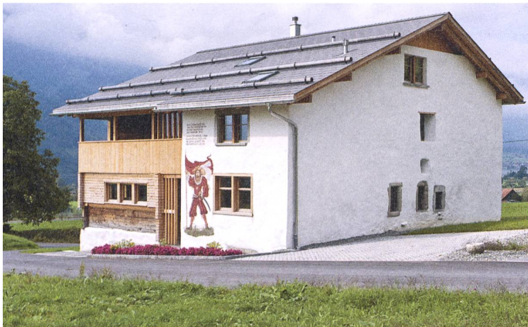
Abb. 11: Das Köplihaus in Seewen SZ. Während das Vorderhaus an mittelalterliche Holzbauten erinnert, ist das ganze Hinterhaus massiv gemauert. Neben der Haustüre die monumentale Darstellung des Erbauers des Hauses, Hans Ceberg.
