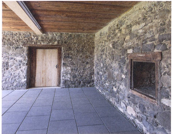
Abb. 13 und Abb. 14: Die Küche, vom Gang durch einen Sandsteinbogen abgetrennt, und der Keller mit in die Wand integriertem Kühlschrank zeigen die bauliche Qualität des Gebäudes.
