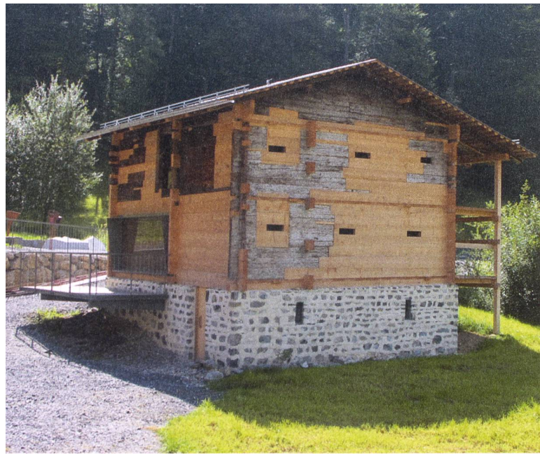
Abb. 7: Das wieder aufgebaute mittelalterliche Holzhaus in der Schornen zeigt heute den Zustand nach dessen ersten Versetzung um ca. 1270.
