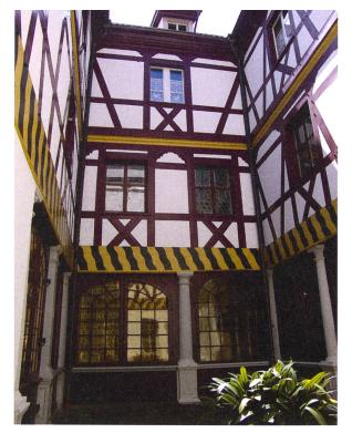
Abb. 22: Der grosse, annähernd quadratische Grundriss des immensen Baukörpers an der Schmiedgasse verlangt zur Belichtung und Erschliessung der Räume einen Innenhof.
