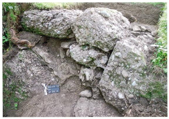
Abb. 4: Schnitt S1, Front der einhäuptig aufgeführten Stützmauer, von SW.
