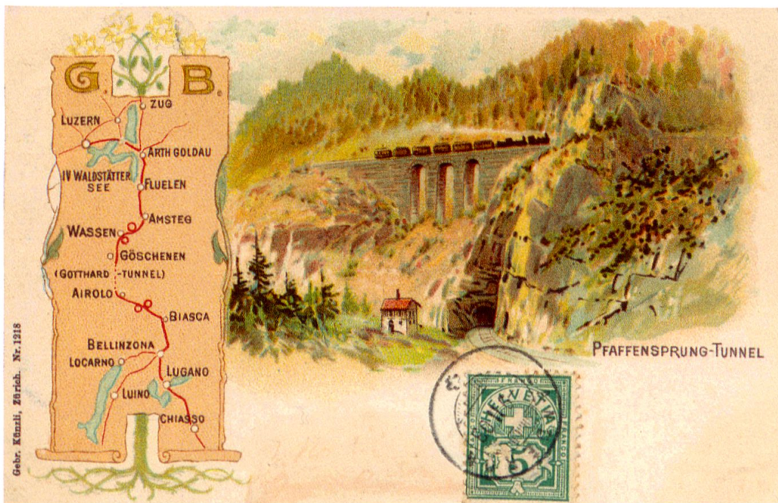
Kolorierte Postkarte um 1898 des Pfaffensprungquertunnels bei Wassen. Im Vordergrund steht, wie die Bahnlinie mit einer technischen Meisterleistung die Alpen bezwingt. (Slg. Roland Arnet)
