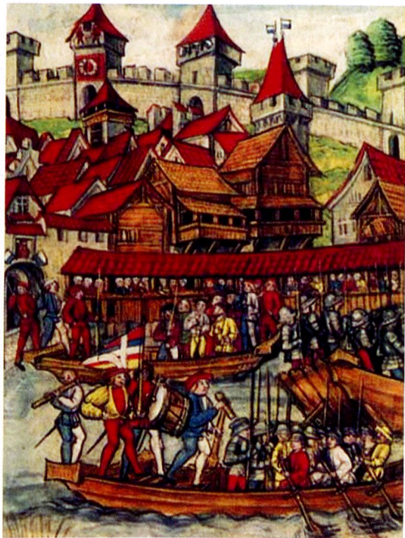
Abb. 6: Traditionelle Lastschiffe als Truppentransporter mit Jochbalken am Heck, seitlich angebrachten und mit Weidenruten befestigten Fahrrudern für die Fortbewegung und einem durch das sogenannte Streichloch gesteckten Streichruder am Heck für die Steuerung. Miniatur aus der Luzerner Chronik des Diebold Schilling, um 1513, fol. 278r («Diebold-Schilling-Chronik 1513») ©Eigentum der Korporation Luzern).
