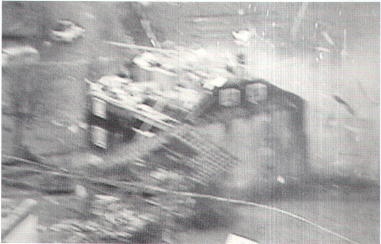
Abb. 1: Die hohen Windgeschwindigkeiten von «Lothar» zerrissen in Oberdorf ein Haus. Zusammen mit der Dauer eines Sturmes sind die Windgeschwindigkeiten und die Böigkeit entscheidend für die Höhe der angerichteten Schäden. Abbildungsnachweis: PFISTER, Naturkatastrophen (wie Anm. 10), S. 17. Abgedruckt ist das Bild auch in WSL/BUWAL, Lothar (wie Anm. 7), S. 101.
