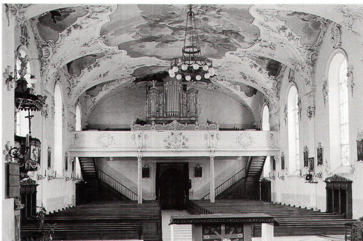
Abb. 38: St. Gallenkappel, Pfarrkirche St. Laurentius und Gallus. Innenaufnahme vor der Restaurierung 1975– 1978. Blick gegen die Empore. (Dmpfl. Kt. SG Bildarchiv).
