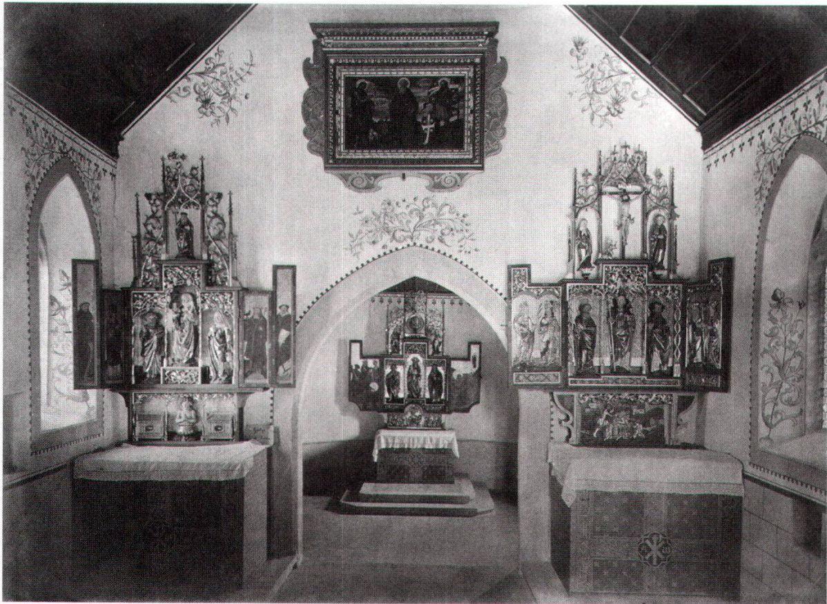
Abb. 32: Altendorf, Kapelle St. Johann. Innenaufnahme nach der Renovierung 1891/92 bei welcher die Empfehlungen von Albert Kuhn grösstenteils aufgeführt wurden. (EAD Bern, Fotoarchiv).
