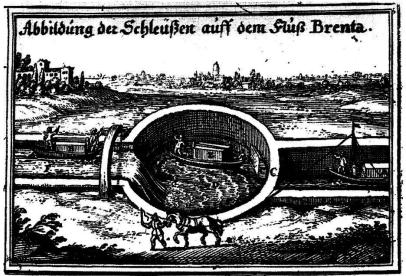
A. Herauff fabrende Schiffe, B. Hinabfabrende Schiffe, C. Hier wirts zagefehloßen, so fullet sich die Schleuße D. und erbebt das Schiffe E. das es dem fluß F. gleich stebet und also farthin febret.
