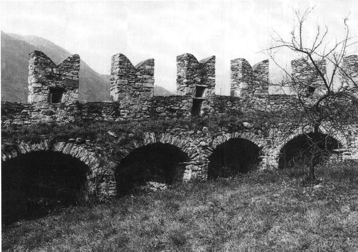
Abb. 2: Innenseite der Ringmauer auf dem Castel Grande von Bellinzona. Der auf Stichbogengewölben ruhende Wehrgang ist feindseitig mit einer Brustwehr ausgestattet, von der aus der Verteidigungskampf mit Armbrust, Hakenbüchse und Steinwürfen geführt werden konnte. Das abgebildete Teilstück der Ringmauer befindet sich in der Übergangszone zwischen dem Castel Grande und der sogenannten Murata; es dürfte im späten 15. Jahrhundert errichtet worden sein.
