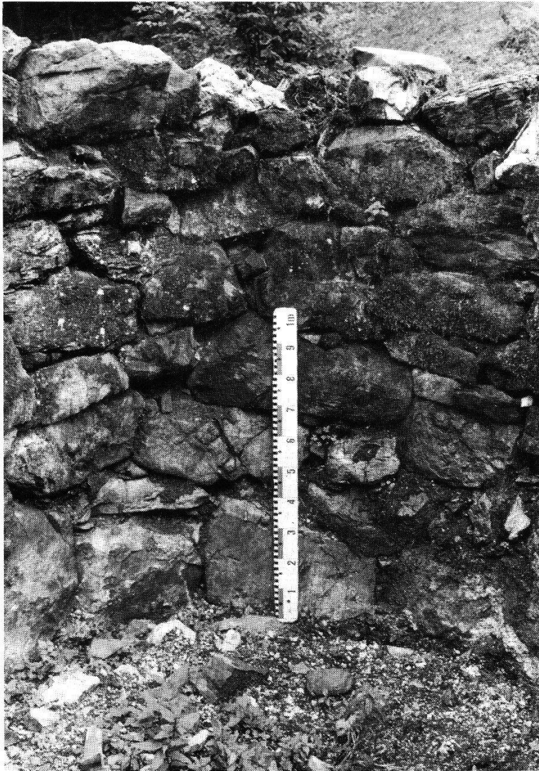
Abb. 8: Kalkofen im Biel, Isenthal: An- sicht des Ofenmantels von innen.
