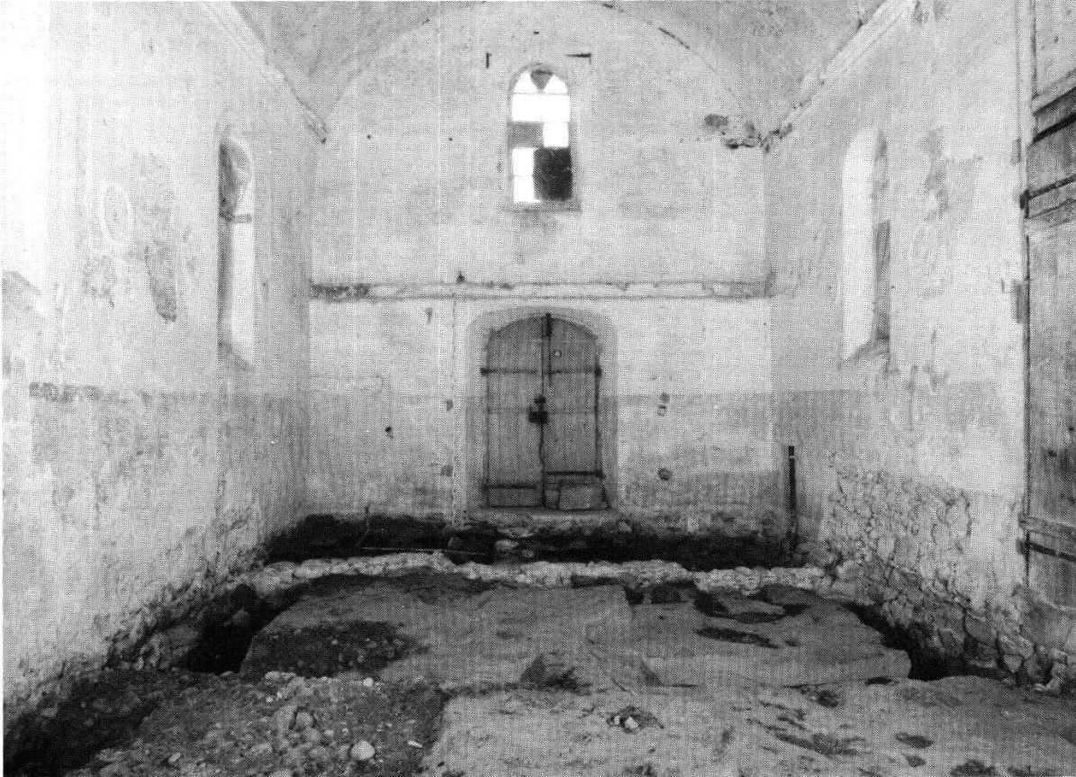
Abb. 6: Alte Kirche Göschenen: Innenraum gegen Westen mit Schiffsverlängerung von 1860; an der Westmauer Abdruck einer Empore über dem Portal.
