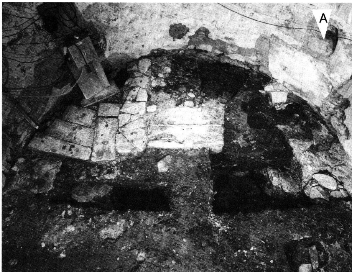
Abb. 11: Alte Kirche Göschenen: Blick in die Bodenzone des Chores. Die Messlatte liegt auf dem Altarblock; links davon Reste eines unregelmässig verlegten Steinplattenbodens, an den jüngere Bodenplatten (1860?) anschliessen. Der Pfeil oben rechts zeigt auf eine originale Nische in der Chorwand.
