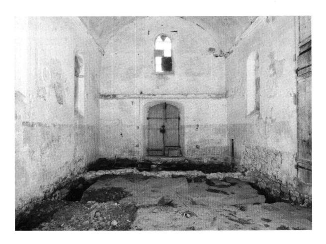
Abb. 6: Alte Kirche Göschenen: Innenraum gegen Westen mit Schiffsverlängerung von 1860; an der Westmauer Abdruck einer Empore über dem Portal.
