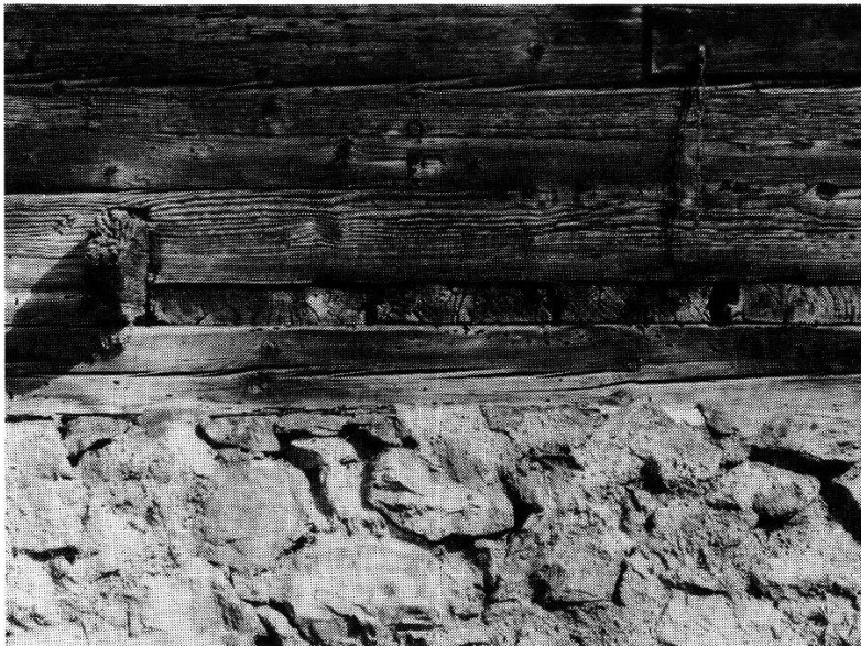
Abb. 1: Fassadenbündige Bodenbohlen (Morschach, Tannen, 1317/41).
