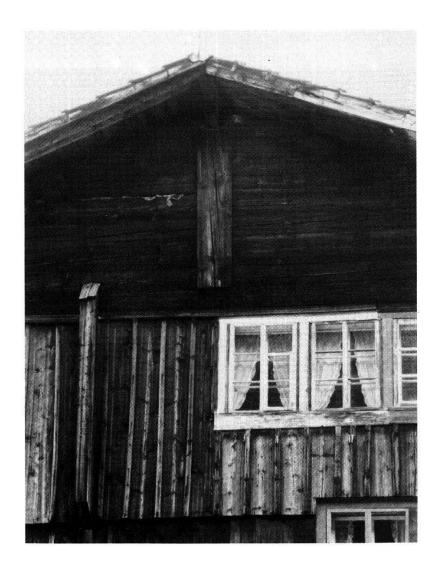
Abb. 4: Spiringen, Mätteli, 1405/08: Fassade Süd mit Firststud.
