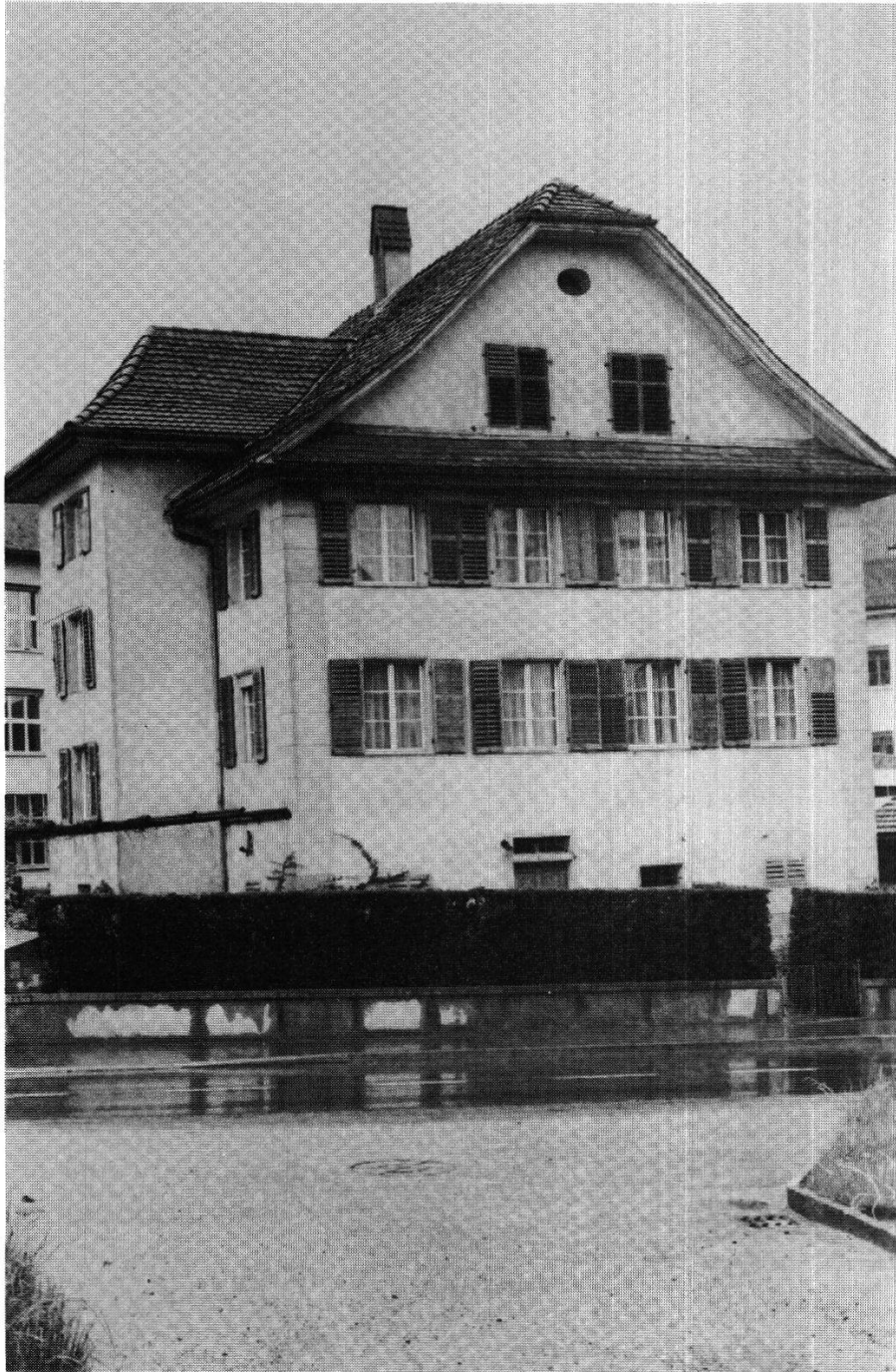
Das Anderallmendhaus in Beromünster (vermutl. 17. Jh.) wurde wie andere Chorhöfe in den Formen des «befreiten» Giebelhauses erstellt.
