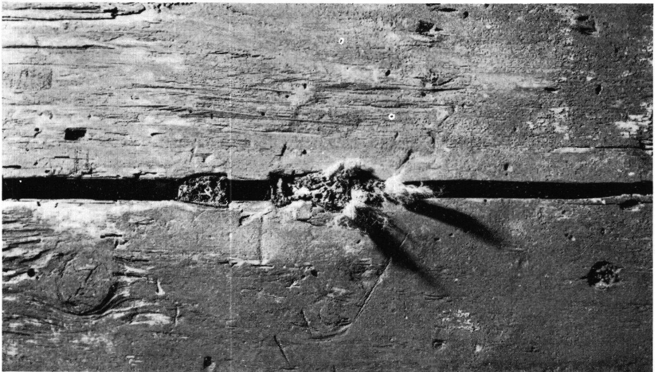
Abb. 10 Kriens-Zumhof Hanfverpflöckung im Schwundriß eines Blockwerkbalkens im Wohngeschoß
