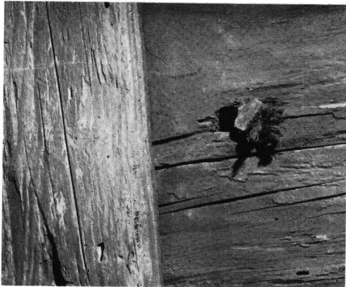
Abb. 7 Zell-Hüswil Hanfverpflöckung am Türpfosten zu einer Schlafkammer im Obergeschoß
