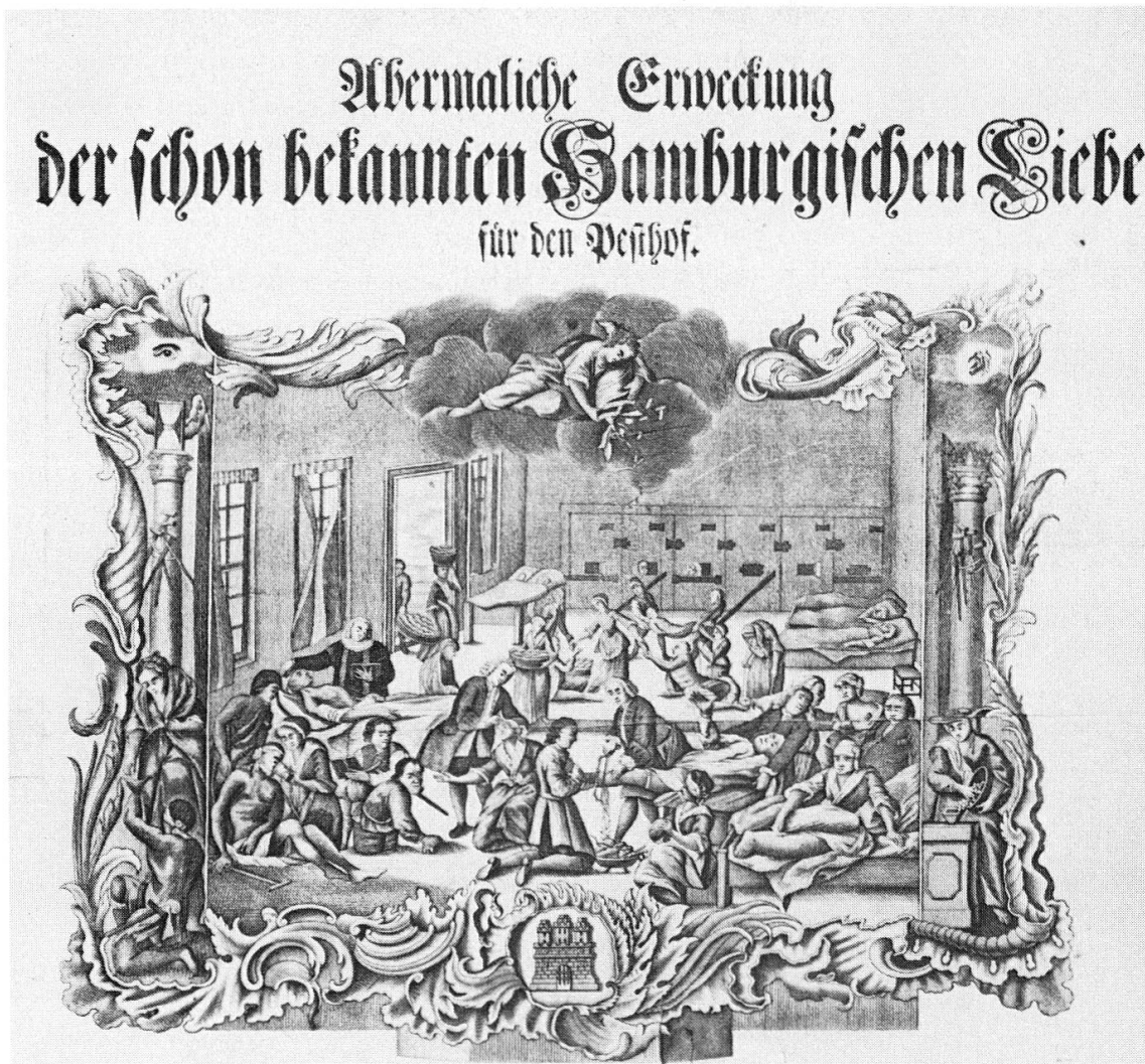
Abb. 4. Blick in einen großen Krankensaal des seit 1606 nachweisbaren Pesthofes in Hamburg, der seit 1742 auf den jährlichen Bittbriefen der Freien Hansestadt immer wieder dargestellt wird. Im Saal werden verschiedene chirurgische Eingriffe durchgeführt; links tröstet ein Geistlicher einen Sterbenden. Im Hintergrund zweischläferige Krankenbetten vor gefängnisartigen Türen; durch zwei geöffnete Ebluken stecken Geistesranke ihr Köpfe. Seit 1797 bezeichnete man diese Anstalt als «Krankenhof». Kupferstich von Philipp Andreas Kilian (1714–1759) nach einem Gemälde von F. S. Heintze. Nachdruck aus dem Jahre 1782 mit dem Aufruf zur Spende durch den Provisor Detlev Nordhoff. Privatbesitz Aachen
