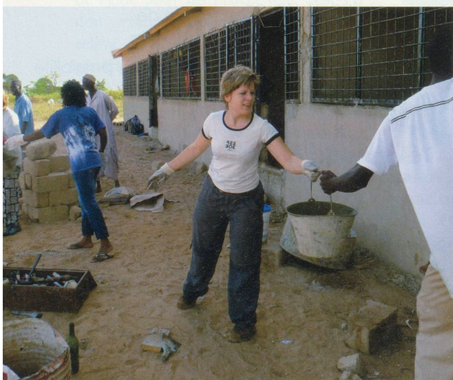
La construction de bâtiments est du ressort d'une équipe locale. Mais les visiteurs mettent eux aussi la main à la pâte.
