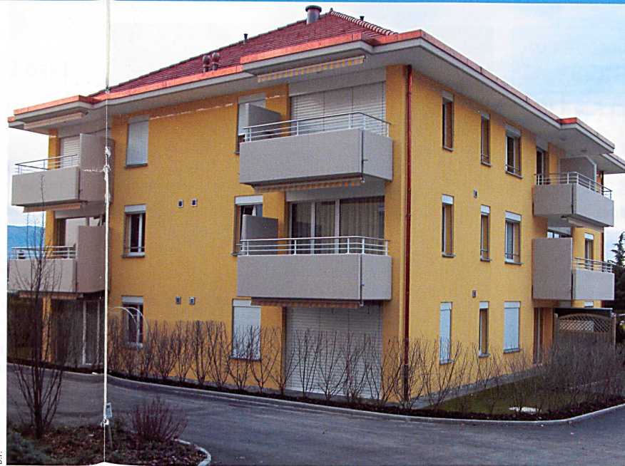
L'un des trois immeubles d'habitat protégé créé à Yvonand.
