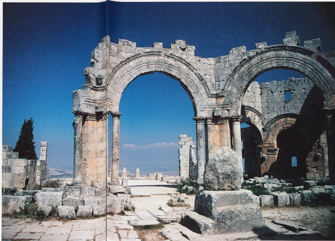
La basilique de Saint-Siméon, dédiée à l'ermite qui aurait vécu sur une colonne
