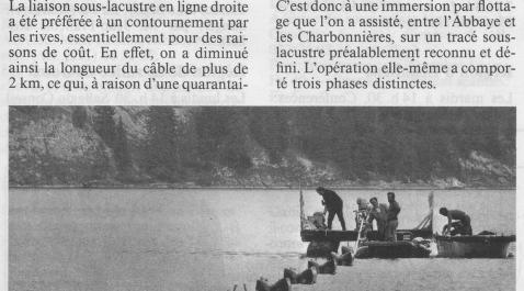
D'abord, l'installation, côté Charbonnières (lieu d'arrivée du câble), d'un treuil de tirage, à partir duquel on a tendu une corde d'acier jusqu'à l'Abbaye (lieu de départ du câble), où se trouvait la bobine de 3 m de diamètre avec son dispositif de déroulement et de freinage. L'extrémité de la corde est alors accrochée à l'extrémité du câble.
