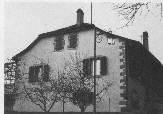
L'ancien bâtiment d'école d'Echandens.
