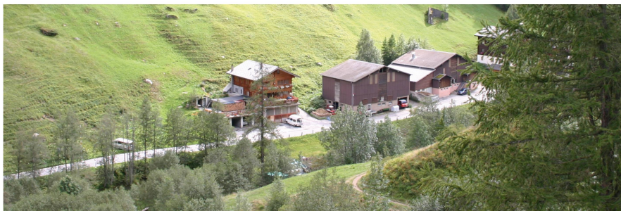
Abb. 4: Blick auf zwei Ökonomiegebäude beim Dorfausgang.
