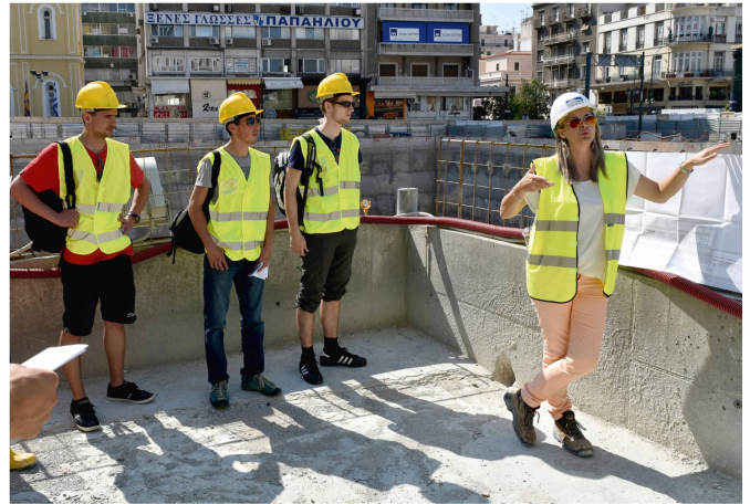
Abb. 2: Führung durch die Baustelle der U-Bahn-Station.
