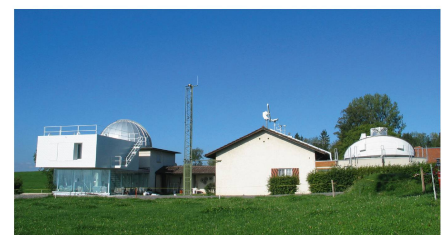
Abb. 18: Geostation Zimmerwald mit Mast der AGNES-Station in Bildmitte (Foto: swisstopo).
