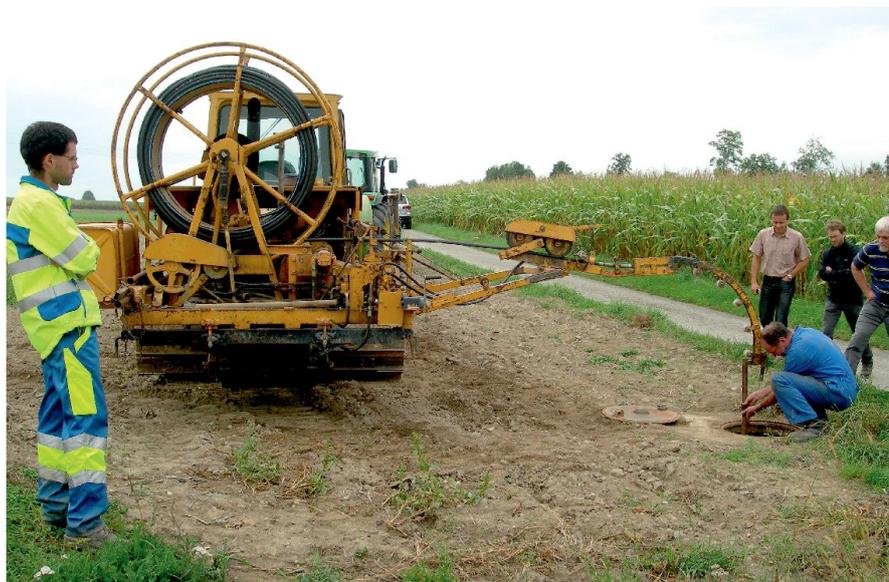
Abb. 3: Spülen einer Drainagesammelleitung (Bild: W. Wehrli).
