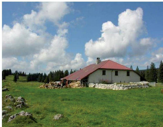
Fig. 9: Citerne alimentée par une toiture.
