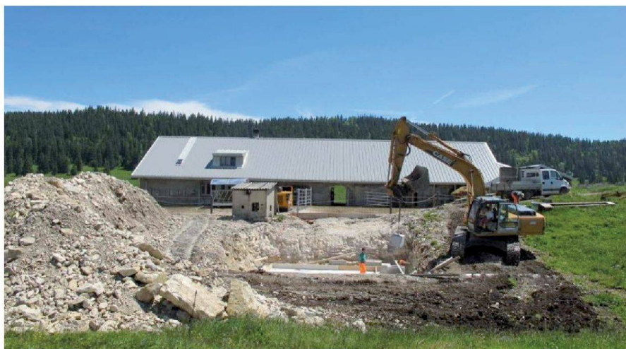
Fig. 3: Réfection d'un chalet: toiture, logement, fromagerie, local d'accueil du public, salle de traite et fosse à purin.
