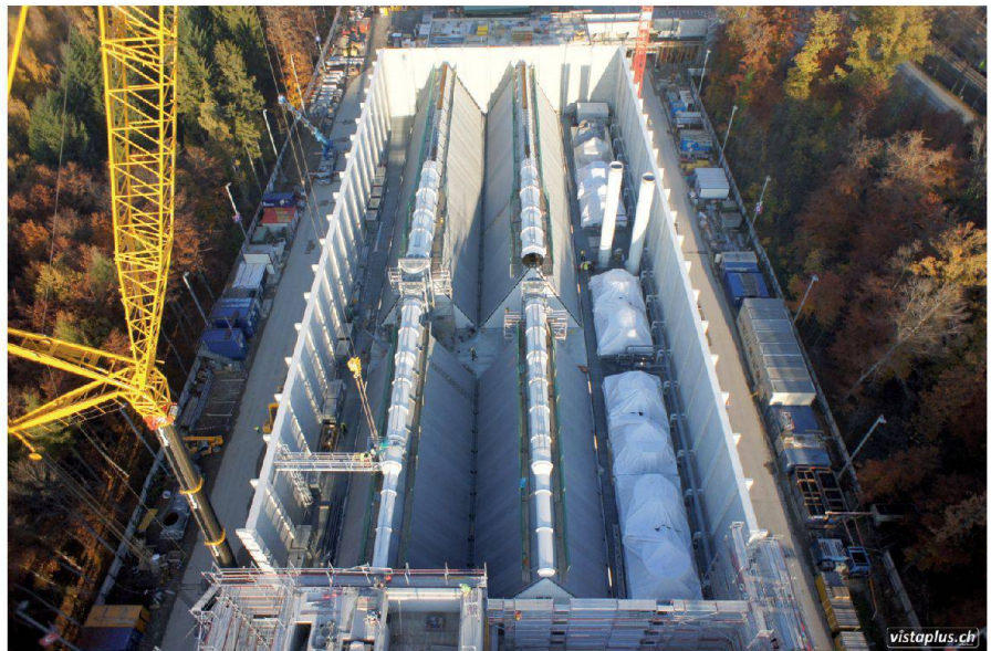
Abb. 4: Blick in das Innere des Gebäudes.
