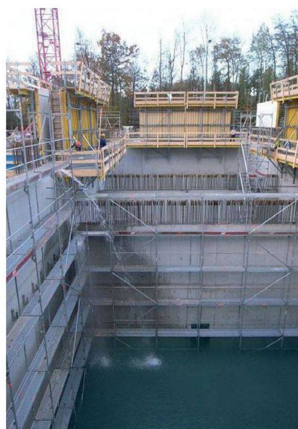
Abb. 3: Der teilweise mit Wasser gefüllte Kehrlichtbunker während den Setzungsmessungen.
