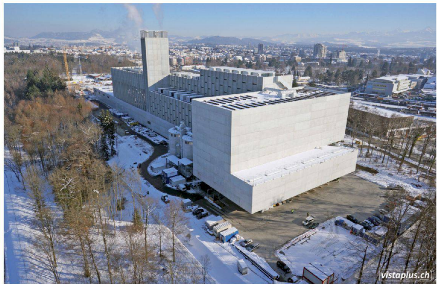
Abb. 1: Das Gebäude, wie es sich am Ende des vergangenen Jahres präsentierte, Blickrichtung Stadt Bern. Die Bauarbeiten sind praktisch abgeschlossen.
