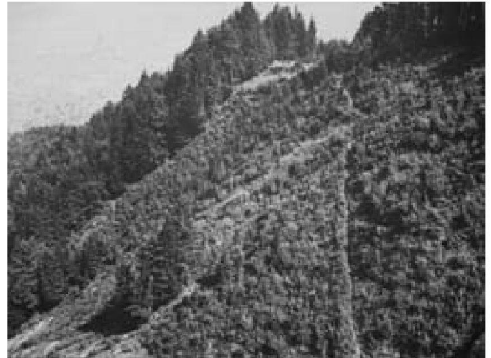
Abb. 2 und 3: Buochserübi. 1934 (links): Hangstabilisierung mittels Flechtwerk und systematischer Wasserableitung (rechts der Bildmitte mit Rollbahn); 1975 (rechts): junger Mischwald im Aufwuchs.
