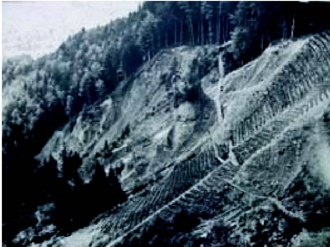
Abb. 2 und 3: Buochserübi. 1934 (links): Hangstabilisierung mittels Flechtwerk und systematischer Wasserableitung (rechts der Bildmitte mit Rollbahn); 1975 (rechts): junger Mischwald im Aufwuchs.
