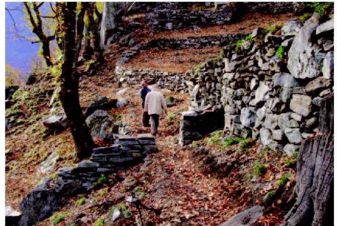
Abb. 3: Revitalisierter Kastanienhain mit Trockenmauern und vorgesehenem Lehrpfad.
