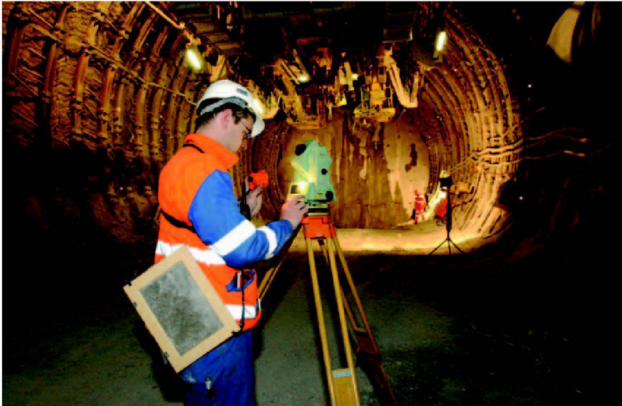
Abb. 2: Stollenkontrolle im Vortrieb Nord West in Sedrun.
