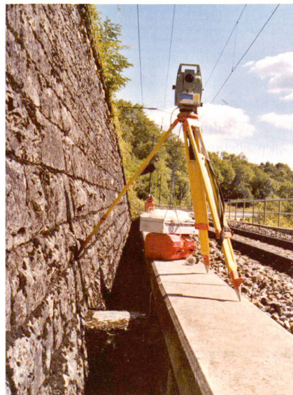
Abb. 2: Unkonventionelle Station unter Einhaltung des Sicherheitsabstandes zum Betriebsgleis.
