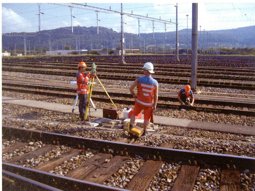
Abb. 1: Geomatikteam mit Sicherheitswärtner bei Absteckungsarbeiten.
