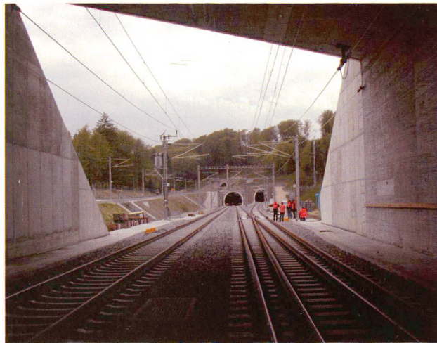
Mattstetten-Rothrist, das Herz von Bahn 2000 ist bereit für den 12. Dezember 2004. / Mattstetten-Rothrist, le cœur de Rail 2000 est prêt pour le 12 décembre 2004.
