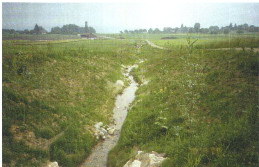
Abb. 12: Der offen gelegte Moosbach bildet eine ökologische Vernetzung und bereichert die Landschaft.
