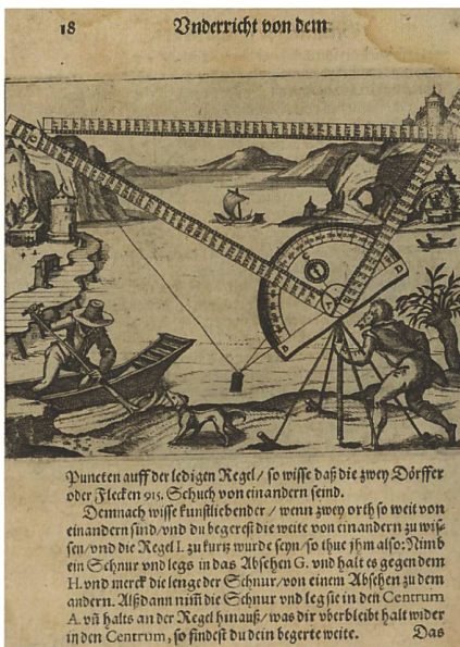
Abb. 5: Vermessung mit einem geometrischen Instrument (Halbkreisscheibe mit Winkelmesser und Kompass und Proportionalwinkel mit drei Schenkeln). Quelle: Leonhard Zubler: Novum instrumentum geometricum (Seite 18).
