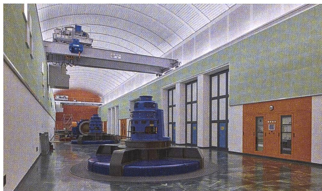
Abb. 4: Centrale elettrica Verbano.
