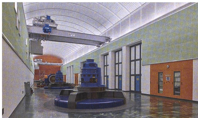
Abb. 4: Centrale elettrica Verbano.
