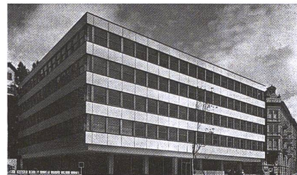
Abb. 1: Das Schulgebäude: Die SSPO belegte zunächst das oberste Stockwerk und später dann auch noch einen Teil der 3. Etage.
