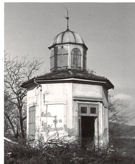
Abb. 2: Der vor 1797 erbaute Pavillon Küpfer auf einer Fotografie kurz vor dessen Abbruch im Jahr 1951 (Staatsarchiv Bern, FN Nydegger 2170, 4).
