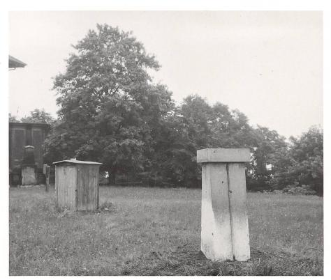
Abb. 12: Gas-Miren und Versicherungspunkte beim Tellurischen Observatorium 1929 (swisstopo).
