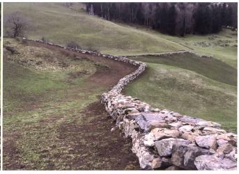
Abb. 4 und 5: Die zweihäuptige Mauer Geissmattli (Seite Obbürgen), welche teilweise nur aus einer Steinbreite bestand, war auf ihrer ganzen Länge instabil. Stellenweise konnte durch die Mauer geblickt werden. Nach der Sanierung: Mit den zahlreichen umliegenden Steinen wurde die Mauer mit einer Breite von ca. 0.8 m neu aufgebaut. Sie stellt ein sehr markantes Element in der Landschaft dar. Zweihäuptige Trockenmauern sind auf dem Gemeindegebiet von Ennetbürgen nicht häufig anzutreffen.
