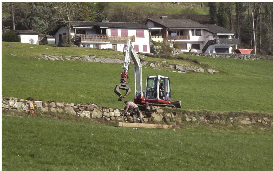
Abb. 6: Sanierung der oberen Grenzmauer im Gebiet Tuschmatt. Hier arbeitet der Grundeigentümer mit. Holztafeln schützen das unterliegende Gelände von wegrollenden Steinen.
