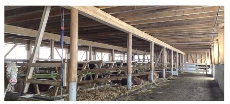
Abb. 2: Laufgang und Liegeboxen mit Trennbügeln – aus Holz.
