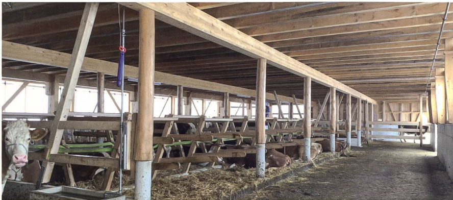
Abb. 2: Laufgang und Liegeboxen mit Trennbügeln – aus Holz.
