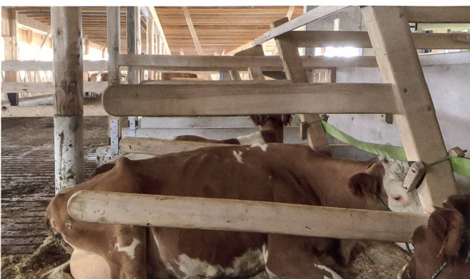
Abb. 3: Die Trennbügel sind vollständig aus Holz gefertigt.
