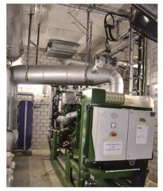
Abb. 2: Der Motor verbrennt das Prozessgas und treibt damit den Stromgenerator an. Die Prozesswärme wird zur Schnitzeltrocknung und zur Gebäudeheizung verwendet. Der Motor steht, damit seine Vibrationen nicht in Umgebungslärm umgewandelt werden, auf Gummiplatten.
