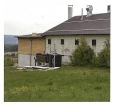
Abb. 1: Ein Teil des Holzkraftwerkes ist in das bestehende Ökonomiegebäude integriert. Dadurch konnte das Bauvolumen und die benötigte Landfläche gering gehalten werden.
