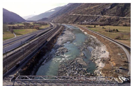
Abb. 5: Erstellte Aufweitung in Fliessrichtung.
