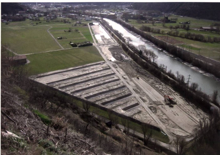
Abb. 2: Aufweitung Baltschieder/Abhumusieren.
