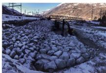
Abb. 3: Bau Leitwerke.
