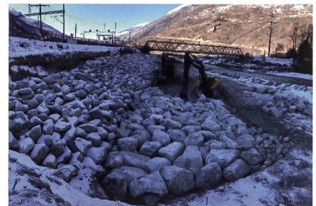
Abb. 3: Bau Leitwerke.
